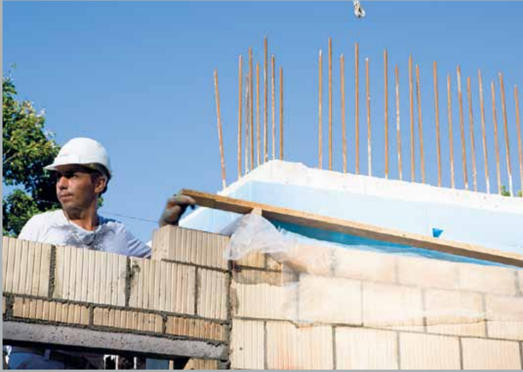
September 2011: Mauern eines Türsturzes (links) und Perspektive der Baustelle aus Optik des Kranführers.
